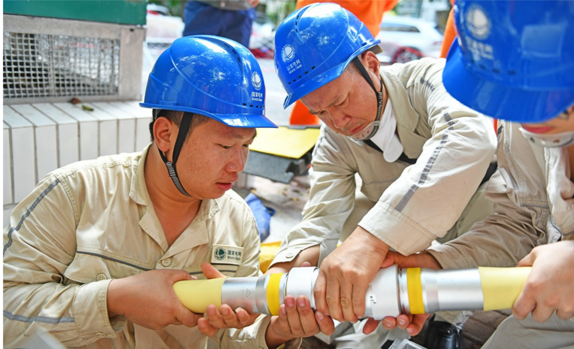
工作人员将中压移动电源车电源接入10千伏天卓#1假日大道环网柜
