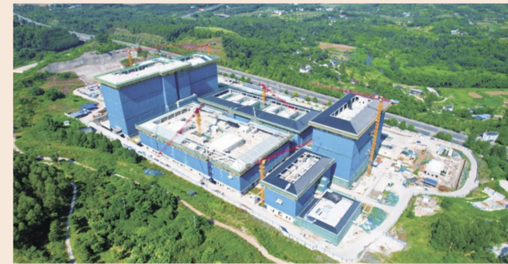
璧山区中医院新院一期项目建设现场
