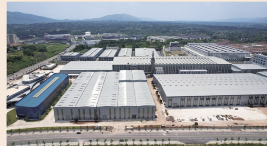
重庆金汇能新材料有限公司项目建设现场
