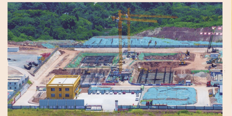
大唐江津燃机项目施工现场
