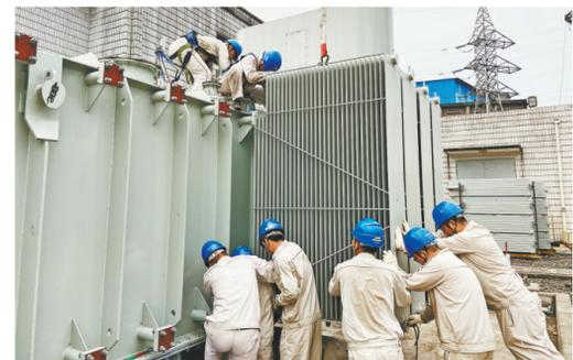
合川供电公司员工在安装变压器散热装置 合川供电公司供图
