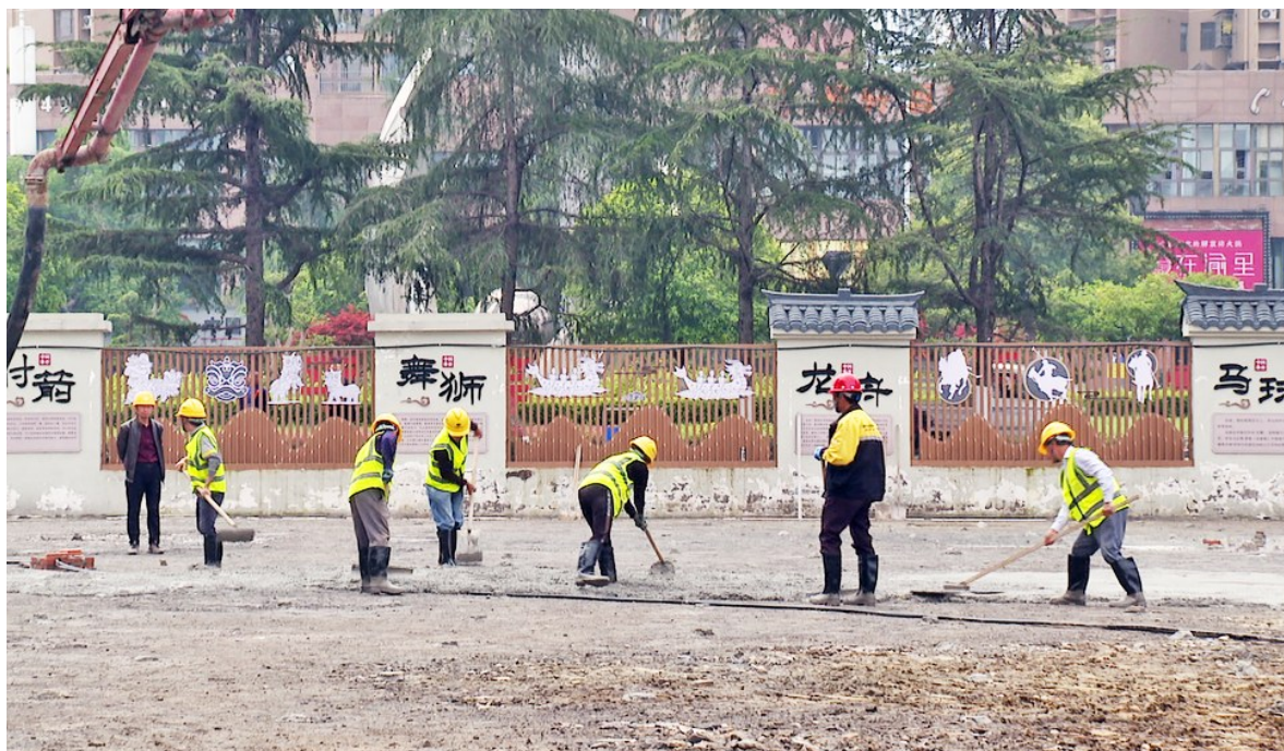
区体育馆改造现场
