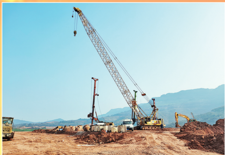
江津区 智能化柔性化生产基地及丘陵山区农用机械研发技术中心施工现场
