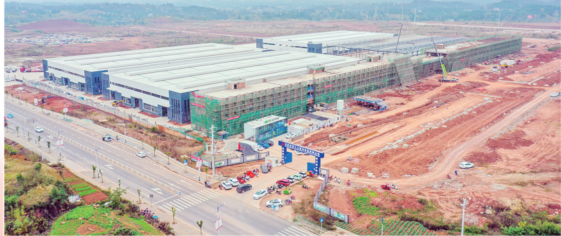
潼南区 遂潼涪江创新食品产业园建设现场
