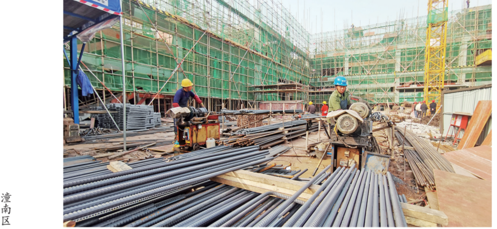
荣昌高新区拾高工业园二期完成总工程量的60%
