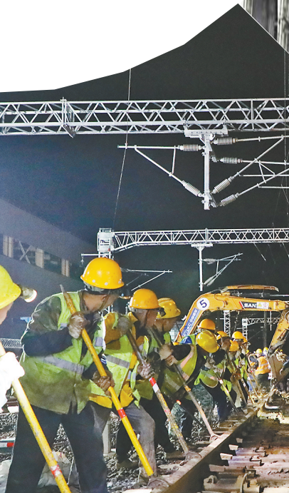
高阳铁路货运站 站场施工现场
