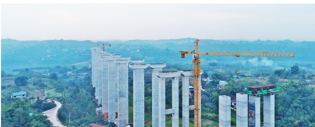
建设中的双钱高速 重庆北新钱双建设发展有限公司供图
