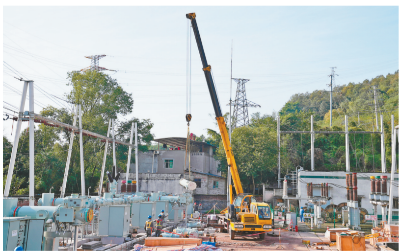
施工现场 合川供电公司供图
