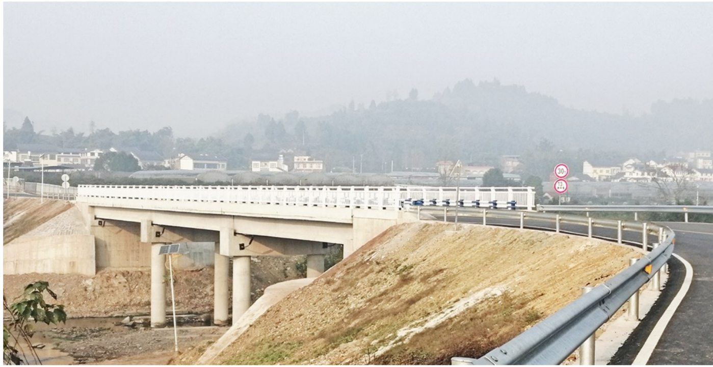
南溪河上的祝家坝新桥
