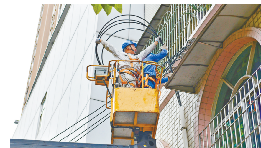
工作人员进行下户线改造作业 合川供电公司供图
