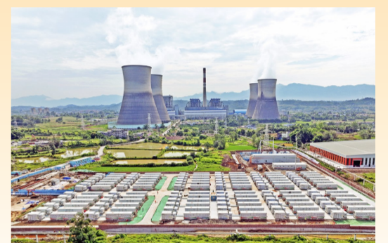
重庆最大新型储能电站——双槐新型储能电站并网投运 通讯员 周克春 摄
