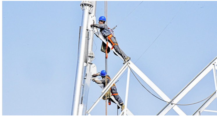
施工现场 合川供电公司供图
