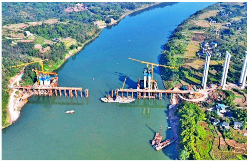
项目建设现场
