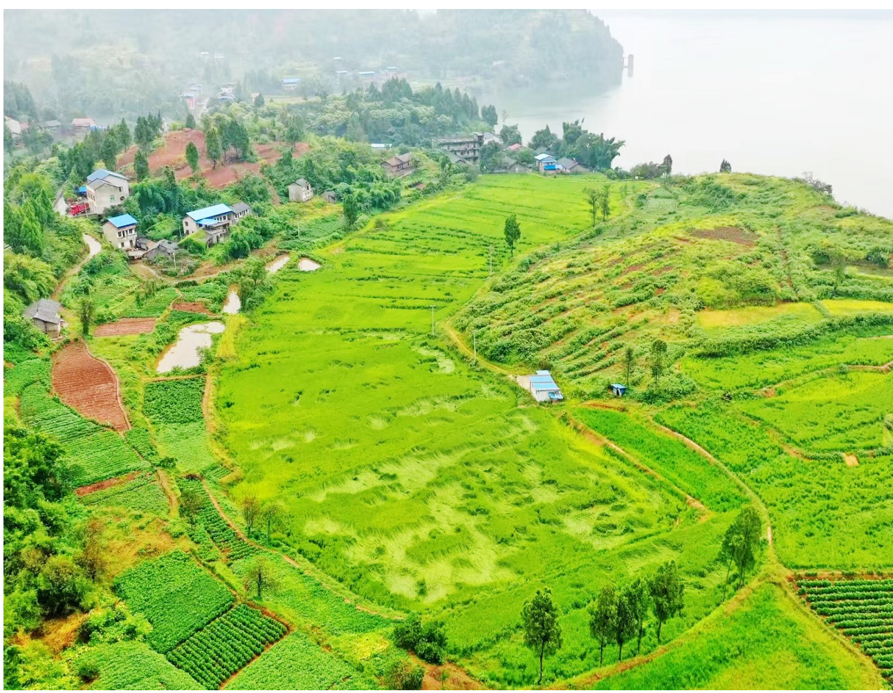
整治后的太和镇石墙村饮用水水源地
