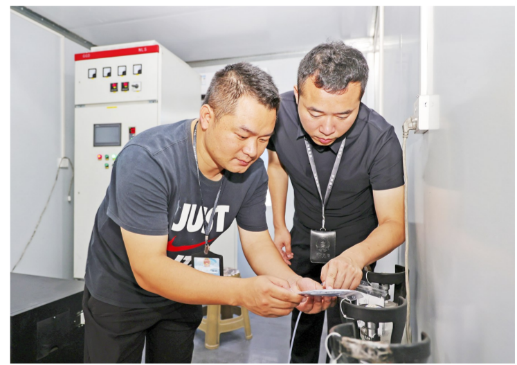
工作人员检查企业环保设施运行情况
