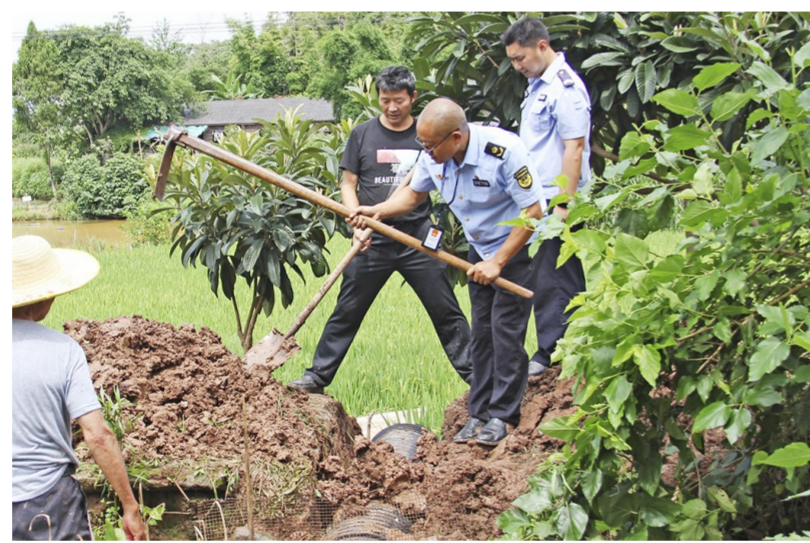
逮平山与群众一道挖掘排水渠做好防汛准备
