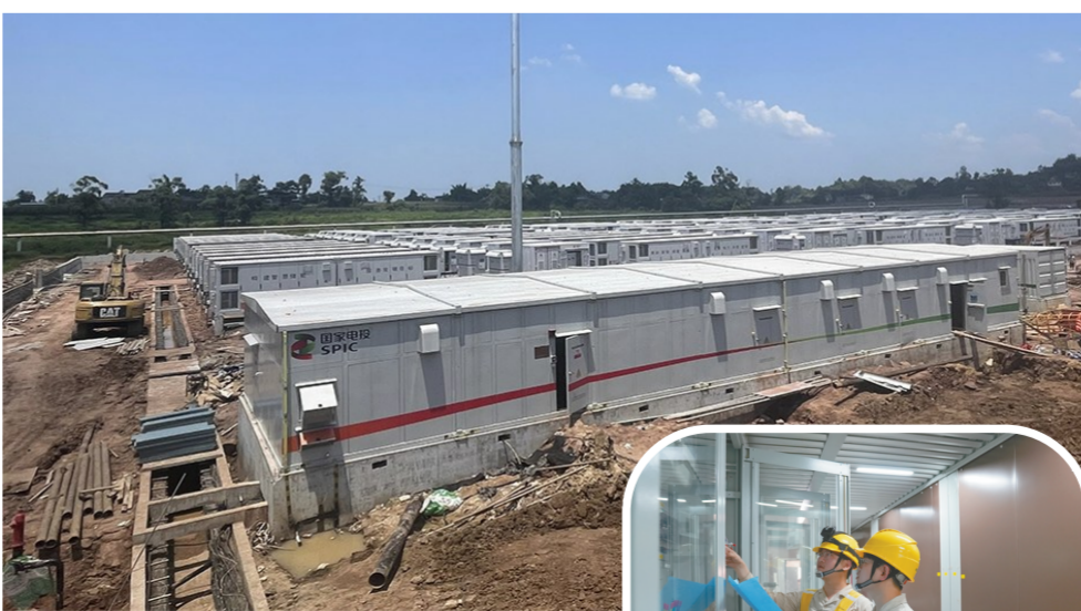
▲建设中的储能电站 ▶工作人员验收计量装置 合川供电公司供图
