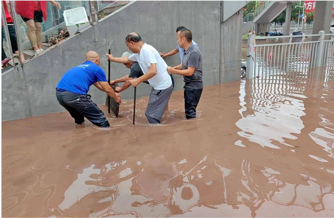
工作人员对雨篦子进行清堵
