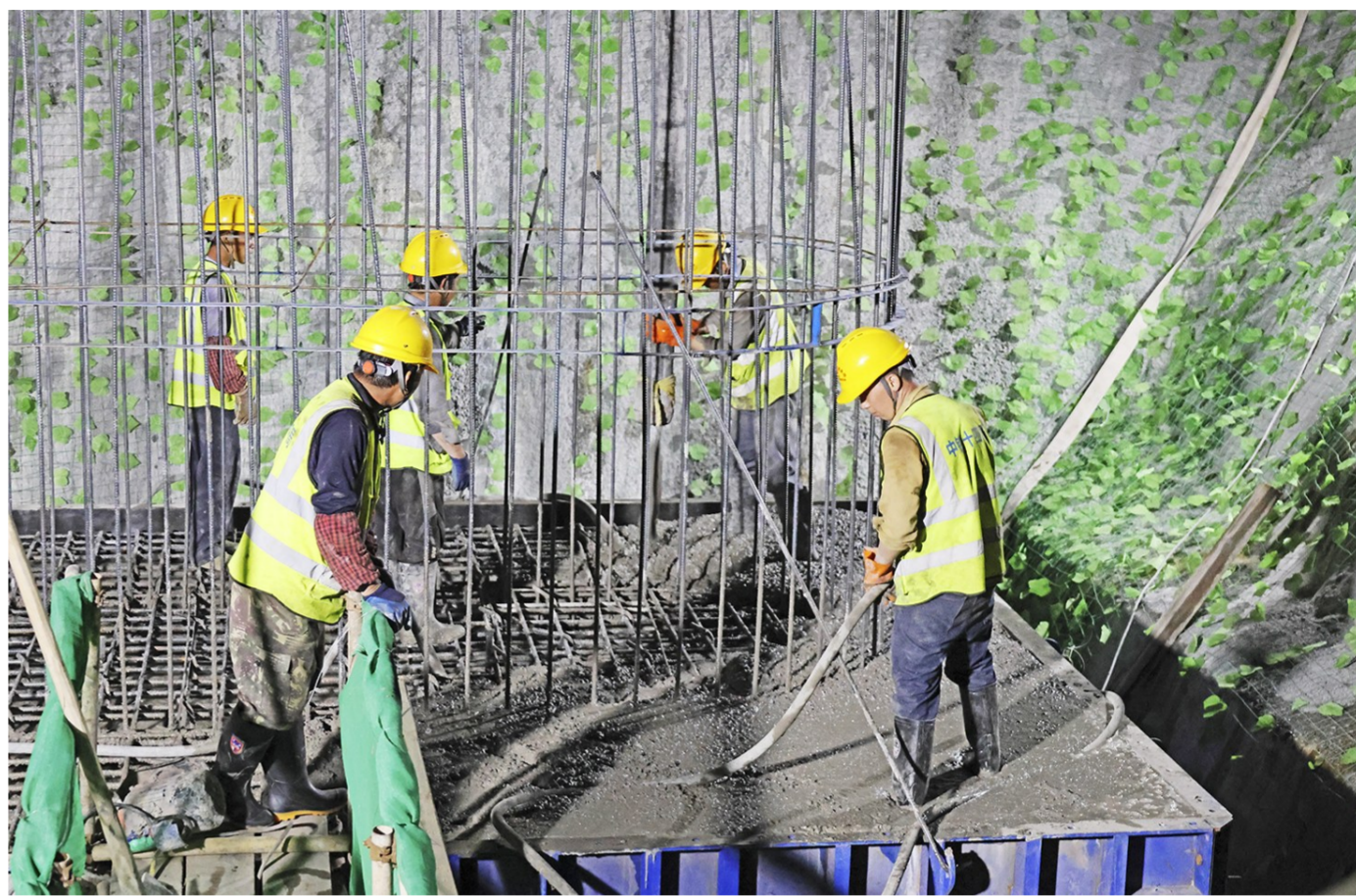
工人在夜间浇筑混凝土
