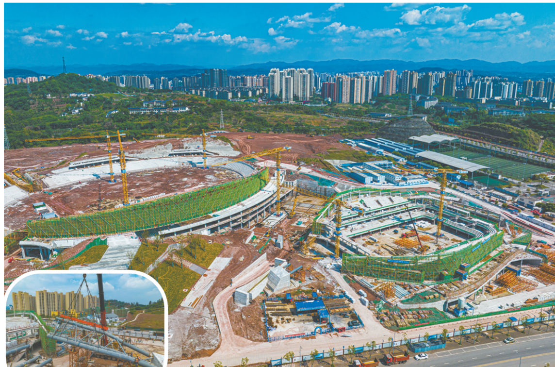
▲钢结构部件开始吊装
