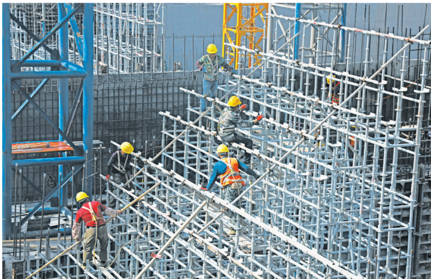
嘉陵江利泽航运枢纽施工现场 记者 任洋 摄
