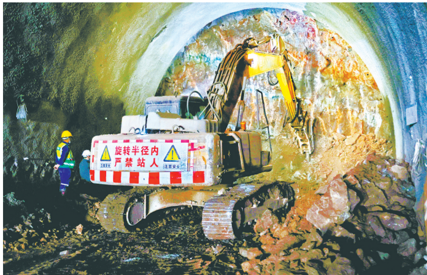
西渝高铁合川东隧道出口施工现场 记者 刘亚春 摄
