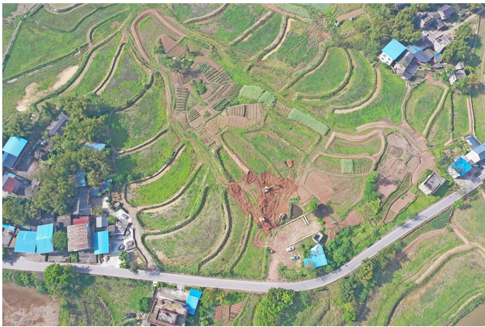
4月15日,龙市镇古城村300亩稻虾综合种养基地开工建设。近年来,该镇按照「乡村振兴、产业先行」的工作思路,结合本地气候条件和农业基础,大力发展稻虾综合种养产业,全力打造稻虾全产业链。
