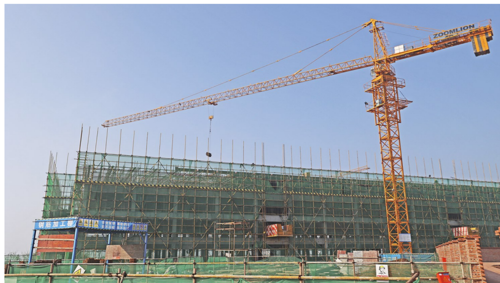
项目建设现场
