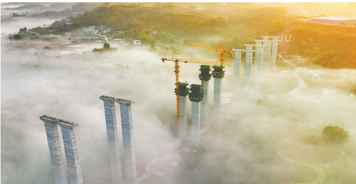
正在建设中的渠江特大桥
