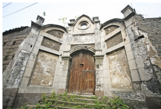
民生公司电灯部旧址
