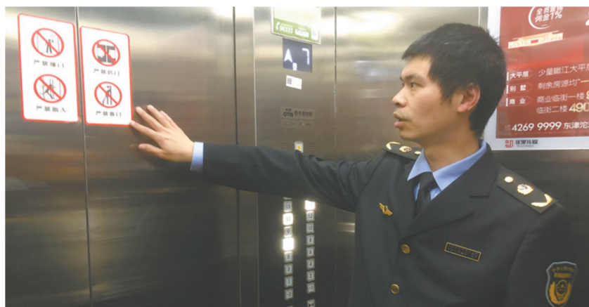
工作人员检查电梯安全标识
