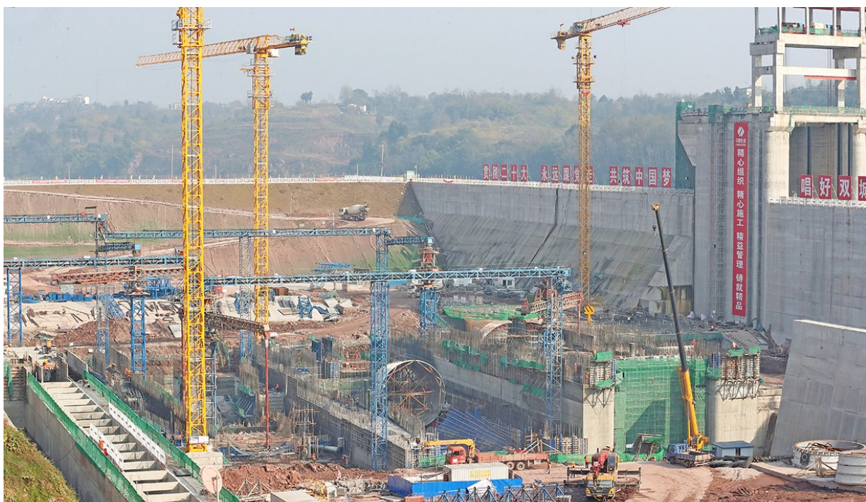
1月9日，记者了解到，川渝合作建设长江上游航运中心重点项目——嘉陵江利泽航运枢纽工程正有序推进中，二期工程已进入大型金属结构安装施工阶段，顺利完成三台水轮发电机组的尾水管安装。图为嘉陵江利泽航运枢纽建设现场。
