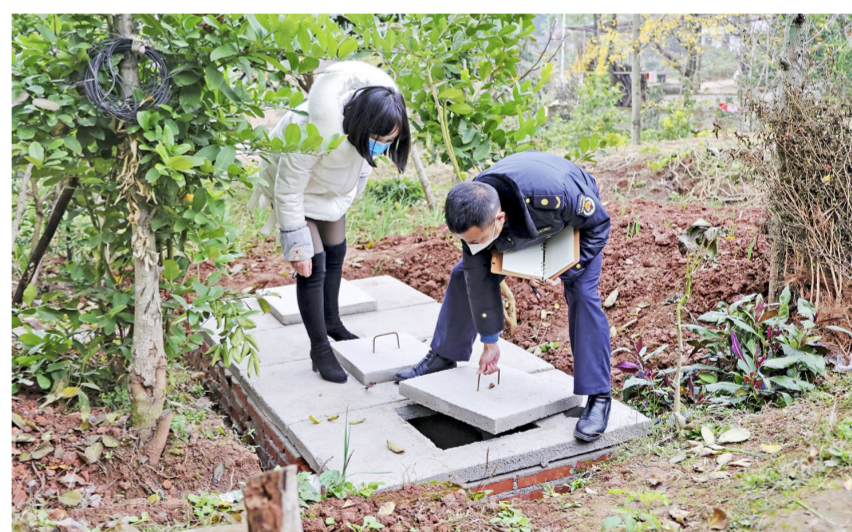
工作人员检查验收新建好的化粪池
