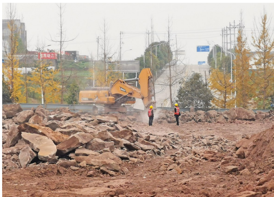
重庆大北农饲料项目建筑工地
