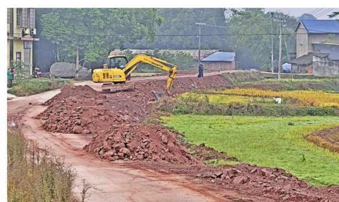
12月9日,沙鱼镇沙佛路燕子村段,挖掘机正对路基进行拓宽作业。针对该镇人大代表提出的《关于提质改造沙佛路的建议》,沙鱼镇政府及时回应,对早期建设的沙佛路实施提质改造,将原4米宽的路面拓宽至6米,切实解决该路安全隐患,方便沿线群众出行。目前,一期工程正式启动,计划改造1公里,将惠及沿线1000多名村民。 记者 李文静 通讯员 王永平 摄
