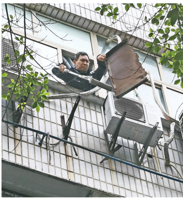
民警正在排除安全隐患
