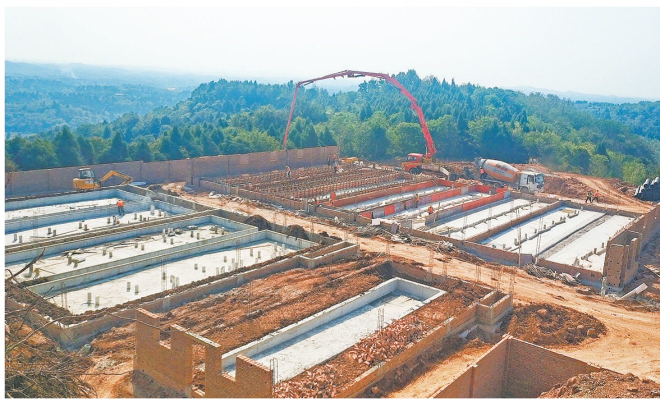
黑猪产业项目建设现场
