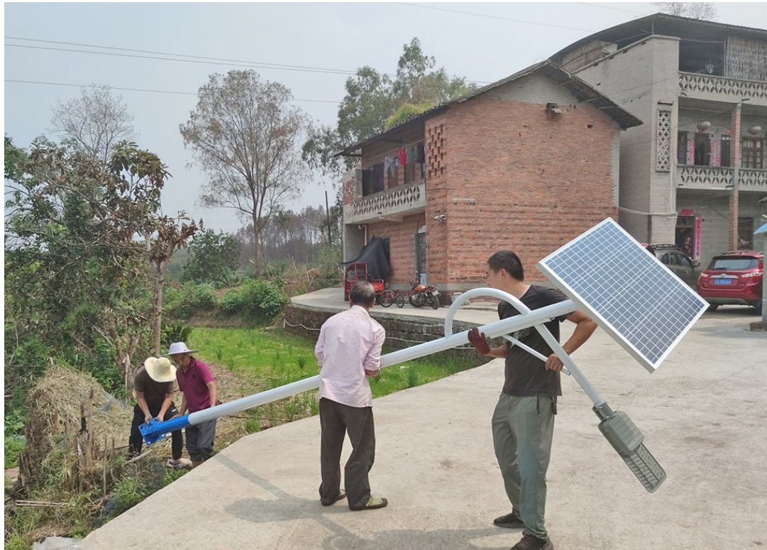
工人在安装光伏路灯
