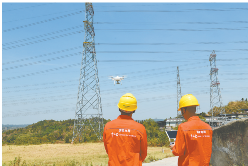
合川供电公司员工运用无人机在220千伏双花南北线巡检
