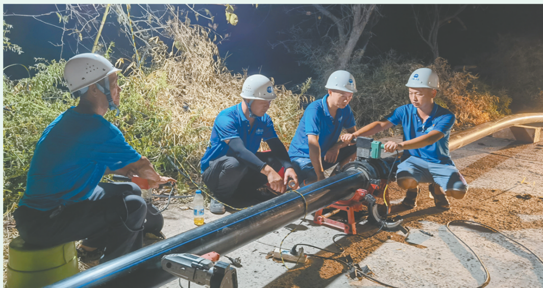
8月18日晚,重庆江城水务有限公司工人连夜抢修钱塘镇水井坡水厂供水管道和增压设施。
