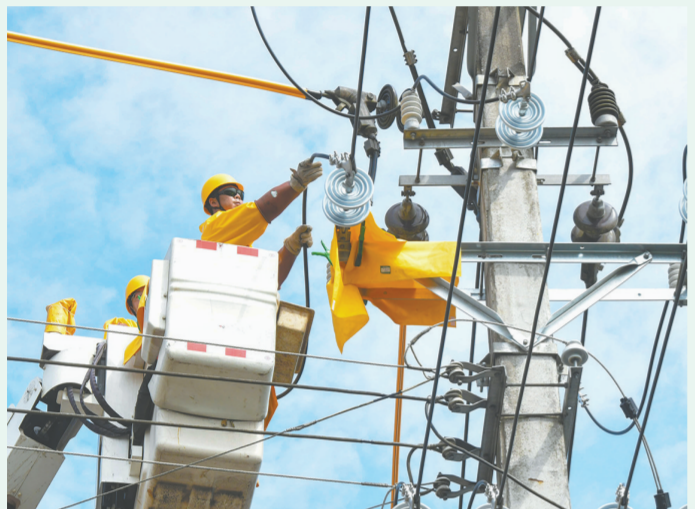
合川供电公司员工在10千伏青利线进行带电搭火作业 合川供电公司供图
