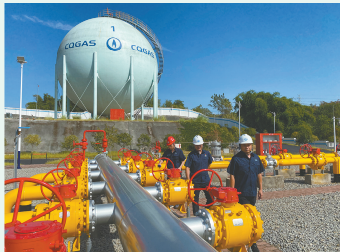
合川燃气公司员工对供气设备进行巡检 记者 袁询 摄
