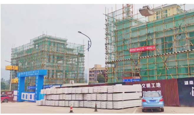
近日,由区工投(集团)公司投资600万元建设的工业园区革新街拓展区邻里中心主体工程完工,建筑面积约1700平方米,包括农贸市场和商业用房2栋建筑,预计7月底全面完工。
