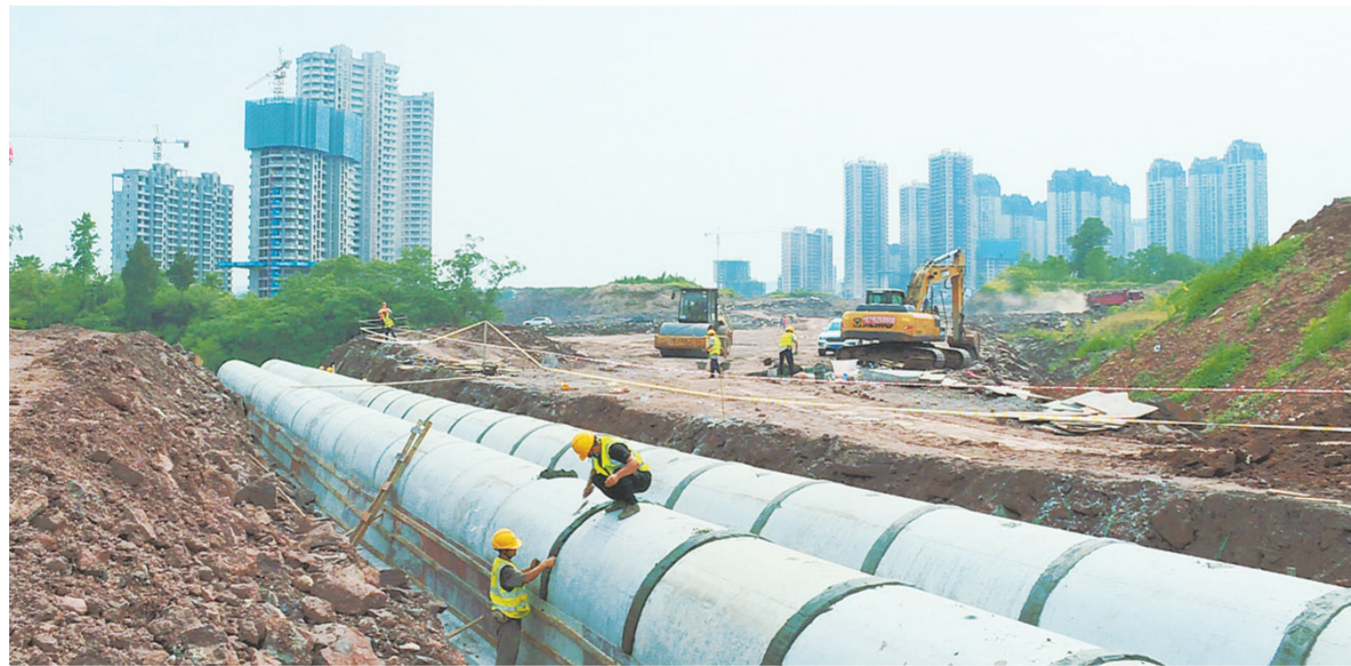
施工人员对两根直径1.5米的管道进行拼接和固定施工
