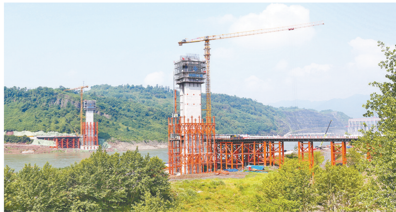
草街嘉陵江特大桥建设现场
