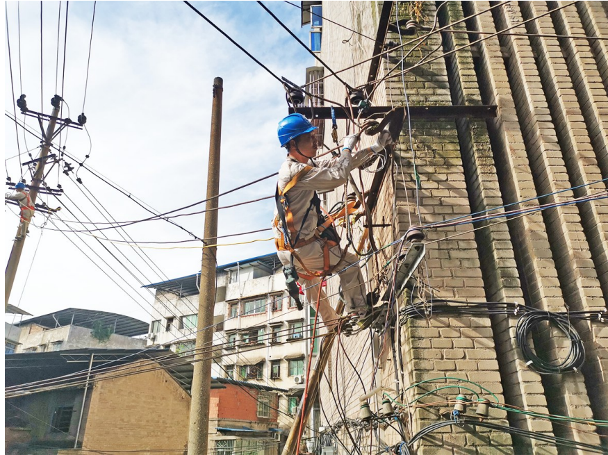
电力工人正在抢修线路
