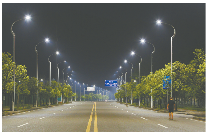
路灯照亮了园区的道路
