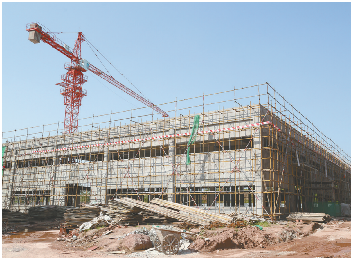
厂房主体已完工
