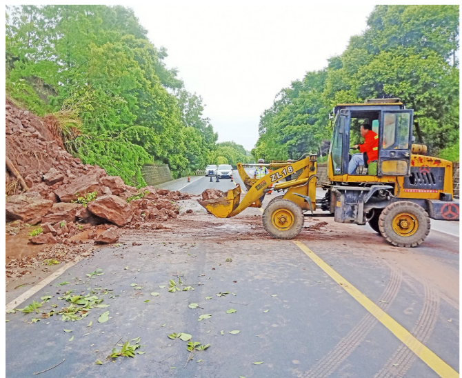
公路抢险现场 区公路事务中心供图
