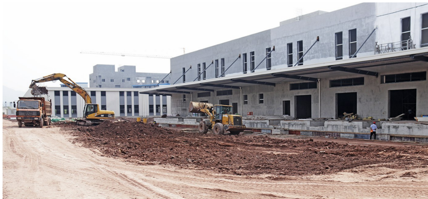
重庆健能医药整体搬迁及扩能项目建设现场
