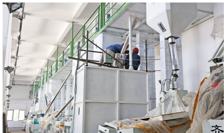
3万吨优质稻米加工项目正在进行设备安装
