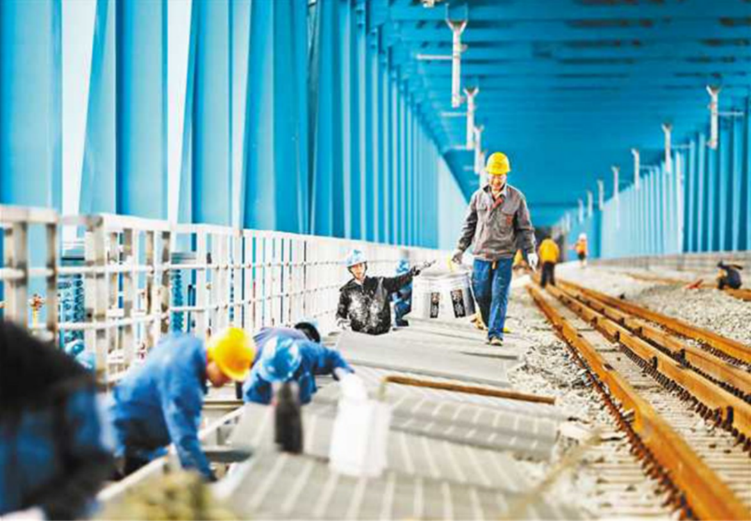
四月十五日,铁路枢纽东环线明月峡长江大桥,工人正在安装护轨和防抛网。
