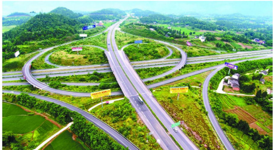
广南高速和成德南高速交会处——李桥枢纽。蒲南平 摄
