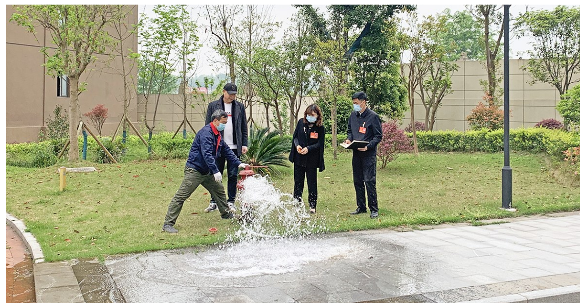
人大代表检查小区消防设施
