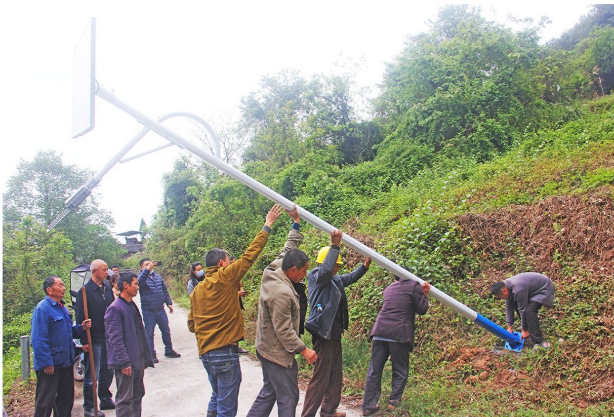
众人正合力安装路灯
