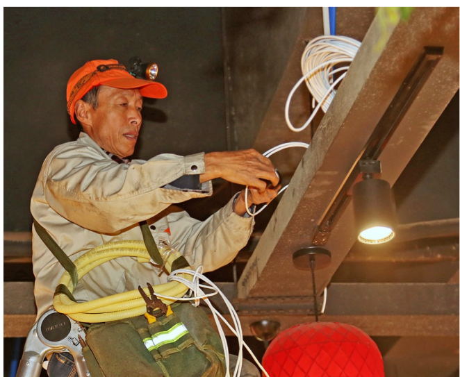
工人正在安装感应探头
