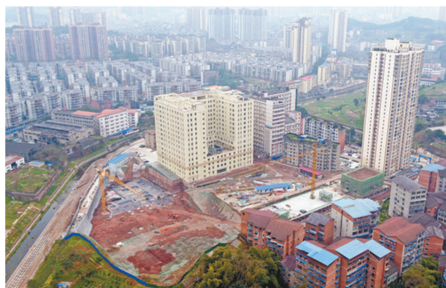
邻水县人民医院传染病区项目建设现场。
