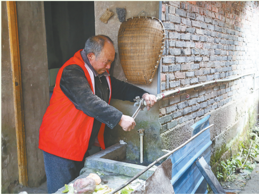
李洪全为村民维修自来水管
